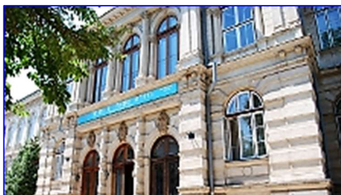
Fațada estică a Institutului
