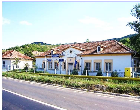
Clădirea dispensarului din Ojasca
