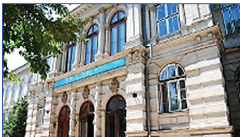
Fațada estică a Institutului
